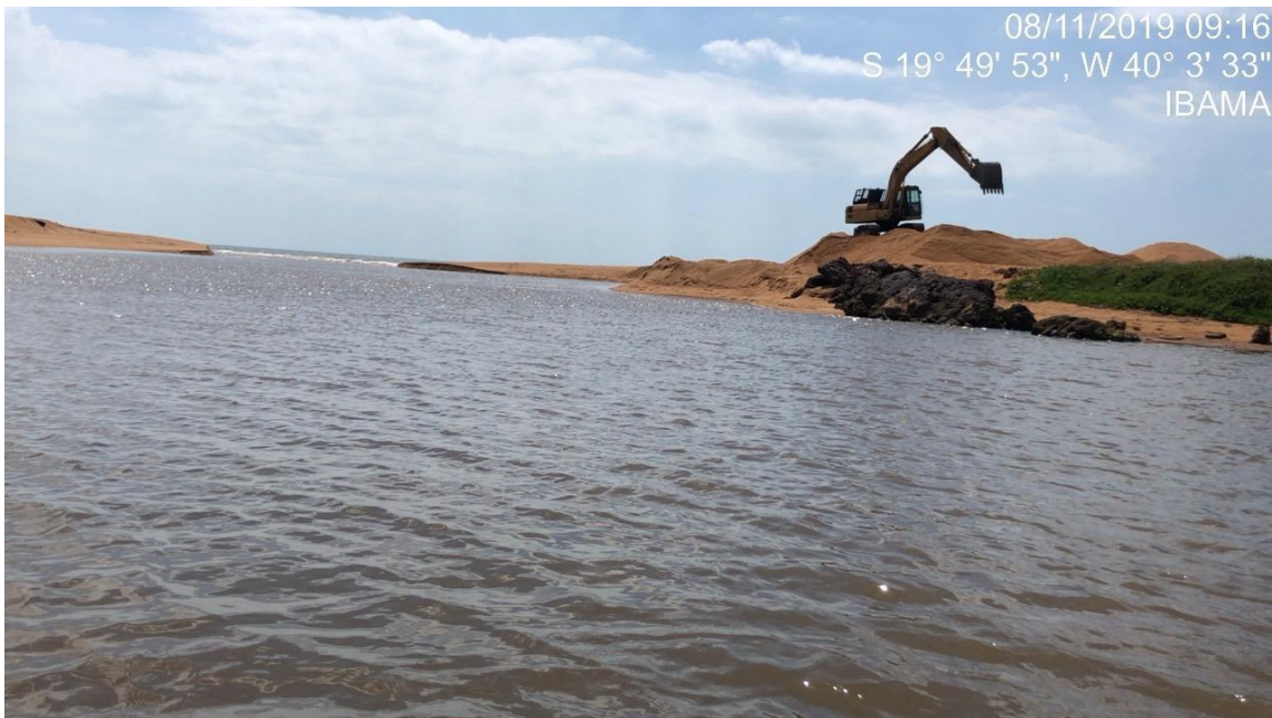
Figura 13: Trator executando a abertura da barra do estuário.
